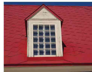
Fig. 83 : Fenêtres des lucarnes du versant sud de la sacristie.
