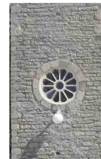
Fig. 86 : Sur la façade principale, on retrouve 2 gros oculi situés sur chacune des tours latérales.
