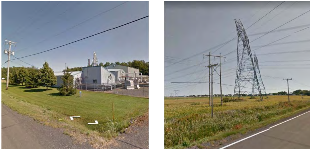
FIGURE 20. Équipements et infrastructures d'énergie
