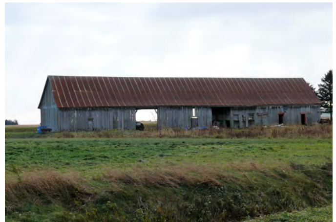
Rare exemple de grange longue à un étage et demi, probablement érigée en plusieurs étapes, au 137, route Commerciale, à Lotbinière.
