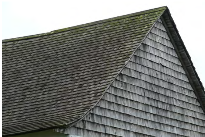
Toiture et pignon d'un hangar revêtus de bardeaux de cèdre et situé au 642, rang Iberville, à Saint-Narcisse-de-Beaurivage.
