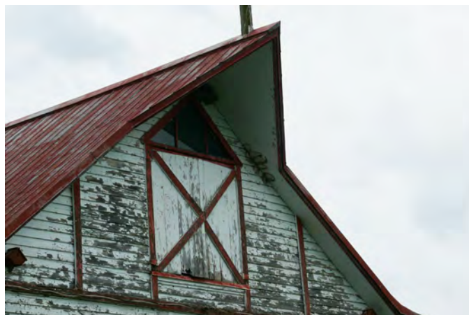
Palan projeté qui domine une trappe d'accès permettant d'atteindre les combles d'une grange située au 1369, rang Sainte-Marie Ouest, à Saint-Sylvestre.
