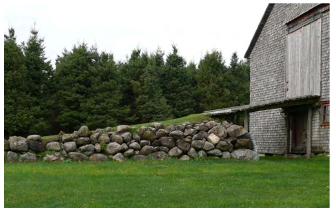
Pont d'accès en pierres des champs sur une grange-étable située au 800, rang 1 et 2 Est, à Saint-Janvier-de-Joly.
