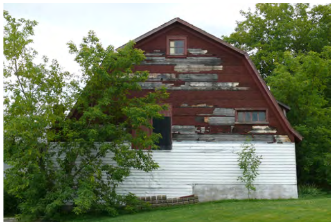
Profil latéral d'un toit brisé courbé sur une dépendance à l'arrière d'une maison ancienne située au 441, rue Principale, dans le village de Saint-Patrice-de-Beaurivage.
