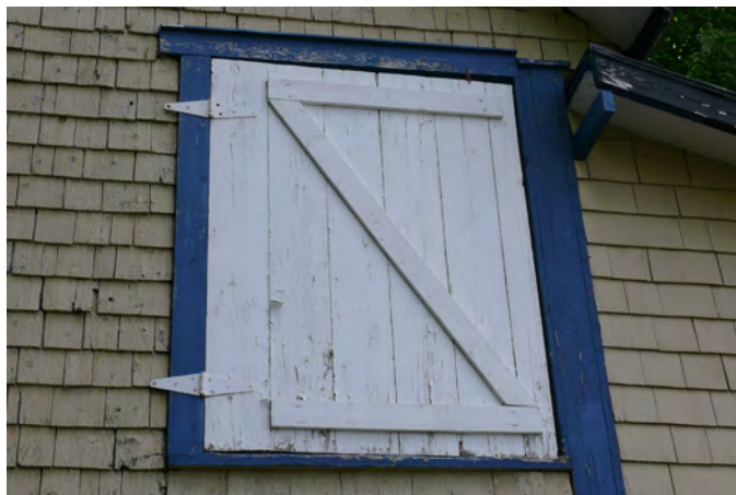
Trappe sur un bâtiment situé au 1149, rue Principale, à Saint-Agapit.
