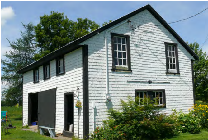
Hangar possédant plusieurs types d'ouvertures et d'accès. 482, route 116, à Saint-Agapit.
