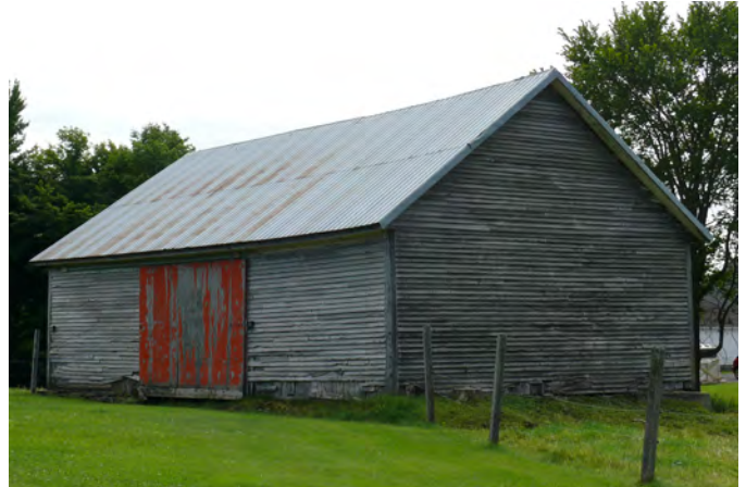
Revêtement de planches à clins sur un bâtiment situé au 984, chemin Gosford, à Sainte-Agathe-de-Lotbinière.
