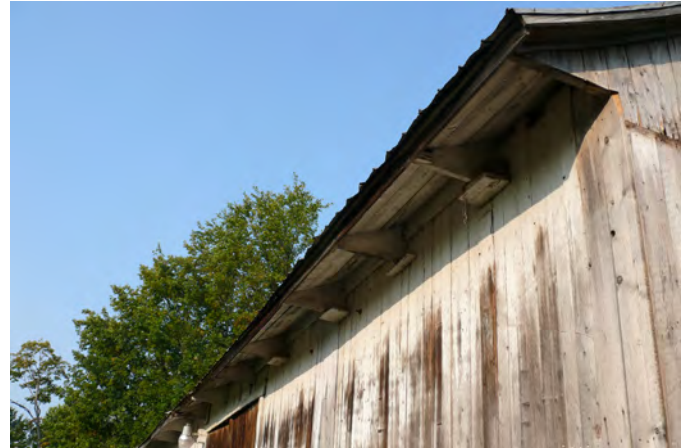
Détail d'un débord de toit d'une grange-étable exposant l'extrémité des coyaux, située au 524, rang Bois-Joly Ouest, à Saint-Apollinaire.
