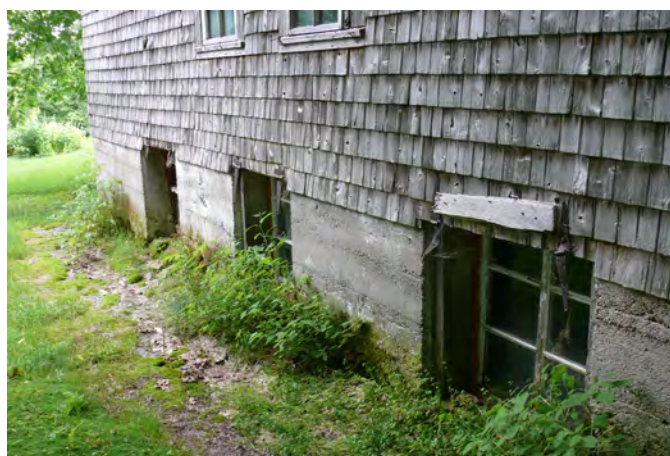
Fondation en béton d'une grange située au 620, chemin Craig, à Saint-Sylvestre.
