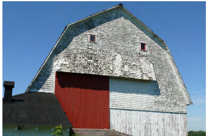
Imposant auvent au-dessus d'une porte coulissante d'une grange-étable située au 276, rang Sainte-Marie, à Saint-Agapit.
