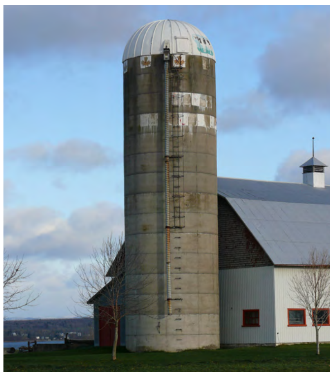
Silo en béton préfabriqué situé au 7694, route Marie-Victorin, à Lotbinière.
