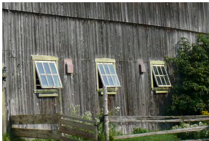
Fenêtres à charnières sur une grange-étable située au 270, rang Pierriche Ouest, à Notre-Dame-du-Sacré-Cœur-d'Issoudun
