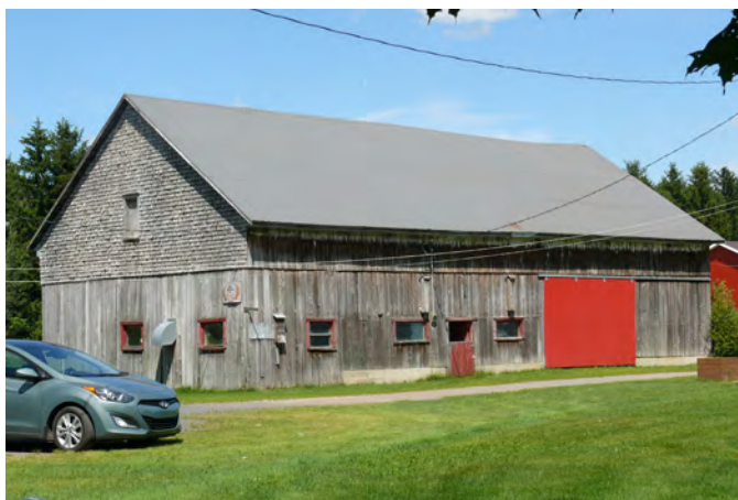
Grange-étable à toit à deux versants située au 209, route Saint-Joseph à Dosquet.
