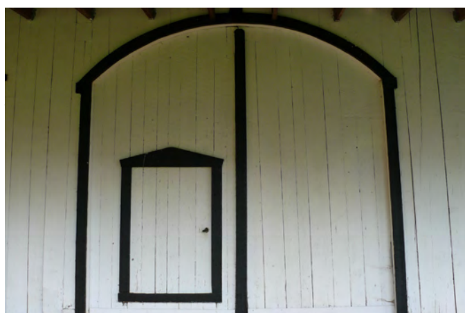
Portes à battants cintrées munies d'un guichet sur une grange-étable située au 318, rang Gaspé, à Saint-Apollinaire.
