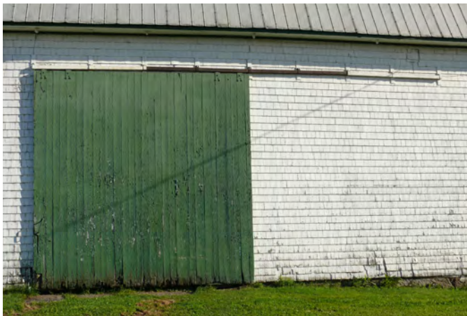
Porte coulissante sur rail sur une grange-étable située au 1240, rue Principale, à Saint-Gilles.
