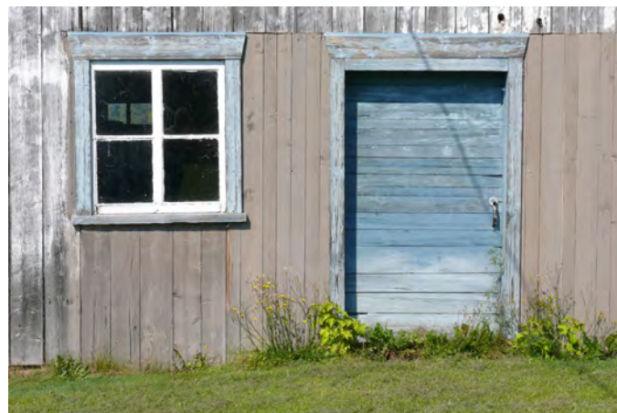
Porte piétonne constituée de planches de bois horizontales sur une grange-étable située au 5040, chemin des Plaines, à Saint-Antoine-de-Tilly.
