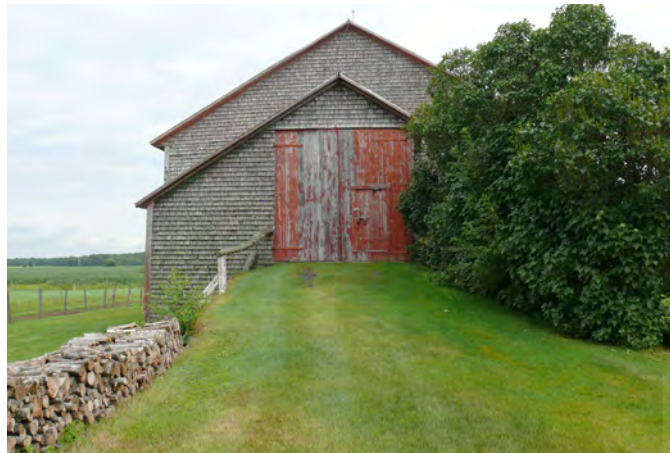
Pont de garnaud couvert au-delà de son talus sur une grange-étable située au 1033, boulevard Saint-Joseph, à Saint-Flavien.
