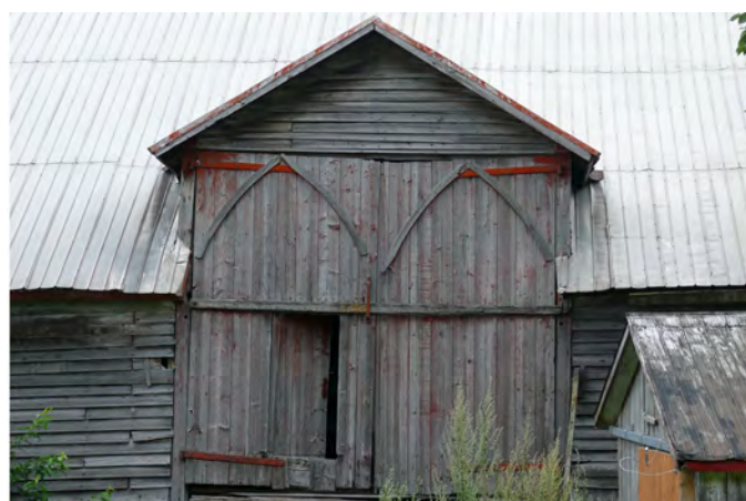
Portes à battants munies d'un guichet sur une grange-étable située au 459, chemin Craig, à Saint-Sylvestre.
