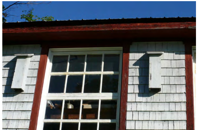
Évents permettant de ventiler l'intérieur d'un poulailler situé au 1452, rue Principale, à Saint-Gilles.
