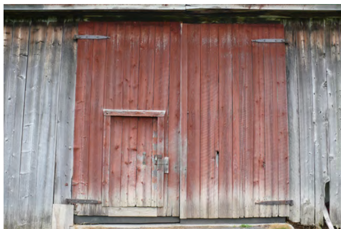
Portes à battants munies d'un guichet sur une grange-étable sise au 950, chemin Gosford, à Sainte-Agathe-de-Lotbinière.
