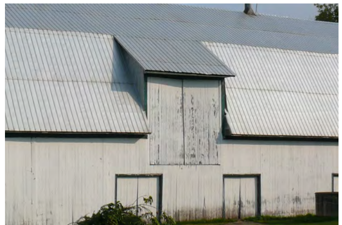
Lucarne de garnaud en appentis dépourvue de son pont d'accès sur une grange-étable située au 353, rang Bois-Franc Est, à Notre-Dame-du-Sacré-Cœur-d'Issoudun.
