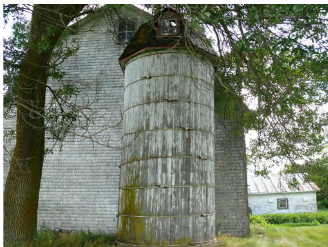
Silo en bois situé au 209, route 269, à Saint-Gilles.
