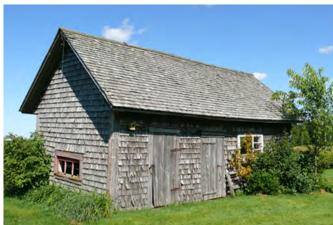
Bâtiment entièrement revêtu de bardeaux de cèdre situé au 1167, 12 e Rang, à Sainte-Agathe-de-Lotbinière.
