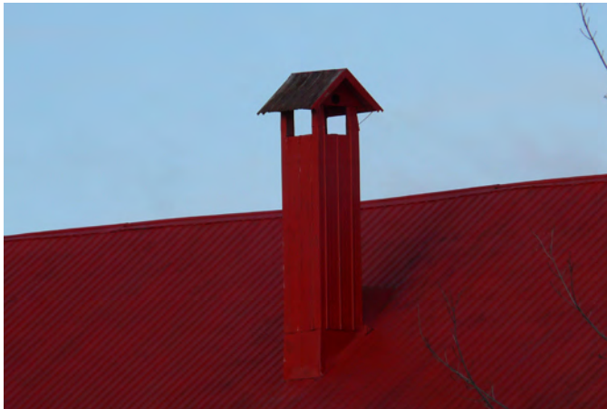
Évent rudimentaire en bois sur une grange-étable située au 7674, route Marie-Victorin, à Lotbinière.
