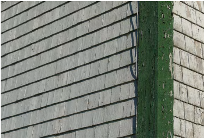
Planche cornière peinte en vert sur une grange-étable située au 1240, rue Principale, à Saint-Gilles.
