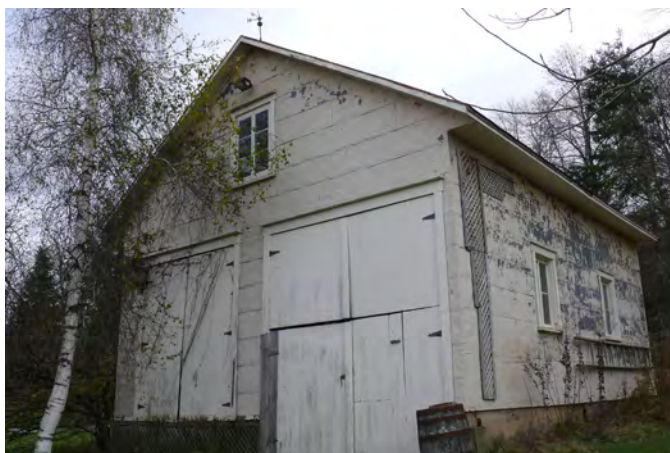
Revêtement de tôle en plaques sur un bâtiment situé au 27, chemin de la Vieille-Église, à Lotbinière.
