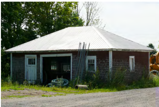
Garage surmonté d'un toit à croupes situé au 154, rue Saint-Georges, à Sainte-Agathe-de-Lotbinière.
