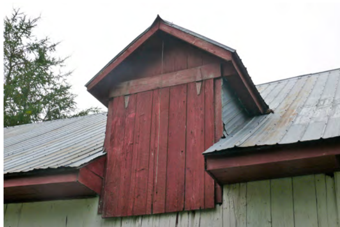
Lucarne à pignon munie d'une trappe sur un bâtiment situé au 442, rue Principale, à Saint-Narcisse-de-Beaurivage.
