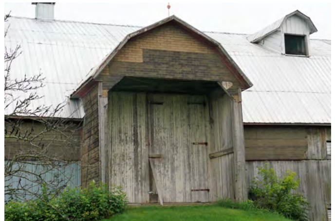
Lucarne de garnaud à toit brisé sur une grange-étable située au 387, rue Saint-Pierre, à Saint-Narcisse-de-Beaurivage.
