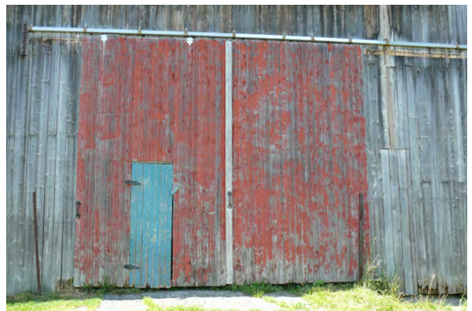
Portes coulissantes munies d'un guichet sur un bâtiment situé au 468, route 116, à Dosquet.
