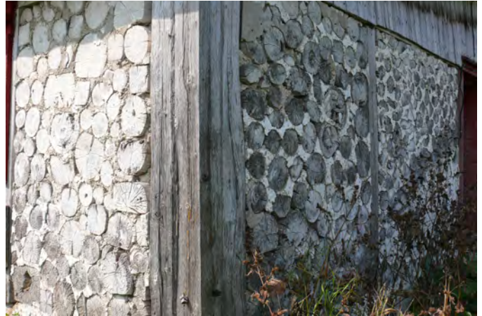
Le volume annexe greffé à la façade principale de cette grange-étable est constitué de billes noyées dans le mortier. 4580, 4 e Rang Ouest, à Sainte-Croix.
