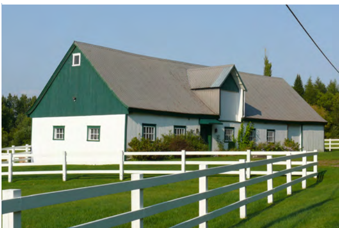
Grange-étable avec toit à deux versants à base recourbée située au 169, rang Saint-Eustache, à Sainte-Croix.
