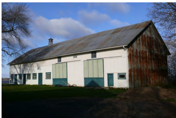
Grange longue à deux étages, construite en 1934, située au 7666, route Marie-Victorin, à Lotbinière.
