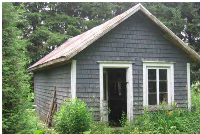
Remise ou hangar situé au 687, rang Iberville, à Saint-Narcisse-de-Beaurivage.
