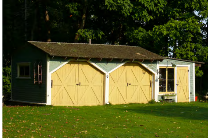
Garage tout en bois, reconstitué avec un aspect traditionnel, situé au 790, rang Pierriche, à Saint-Apollinaire.
