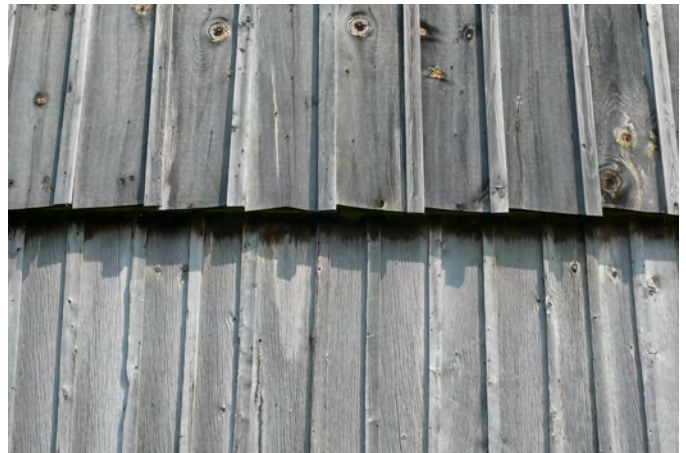
Revêtement de planches à couvre-joint présent sur une grange-étable située au 3740, rang 3 Ouest, à Sainte-Croix.
