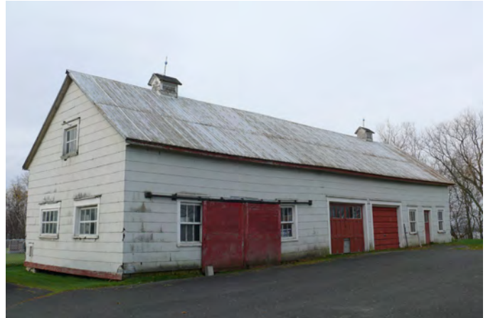
Écurie près de l'église et du presbytère de Leclercville, située au 1014, rue de l'Église.
