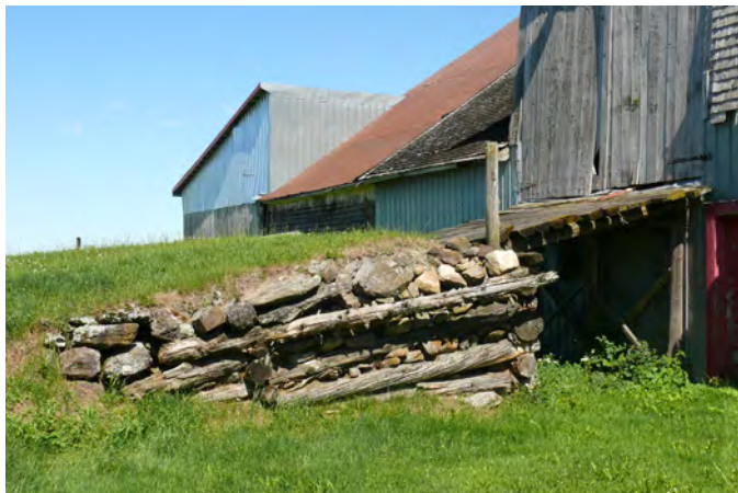
Pont de garnaud en pierres des champs et en pruche sur une grange-étable située au 1051, route de Sainte-Agathe, à Sainte-Agathe-de-Lotbinière.
