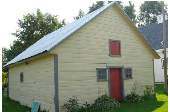
Planches à feuillures sur une ancienne écurie située au 3877, chemin de Tilly, à Saint-Antoine-de-Tilly.
