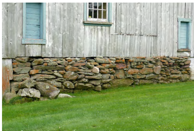
Fondation de pierres sèches soutenant une grange-étable située au 595, rang Saint-Jean, à Saint-Patrice-de-Beaurivage.
