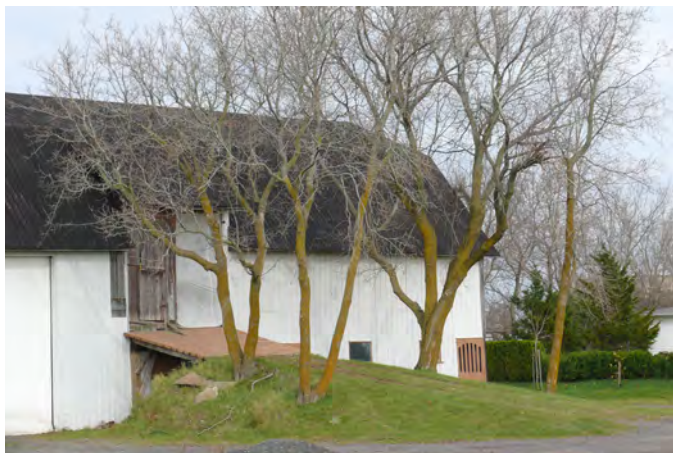
Pont de garnaud en pierres des champs sur une grange-étable située au 2128, route Principale, à Saint-Édouard-de-Lotbinière.
