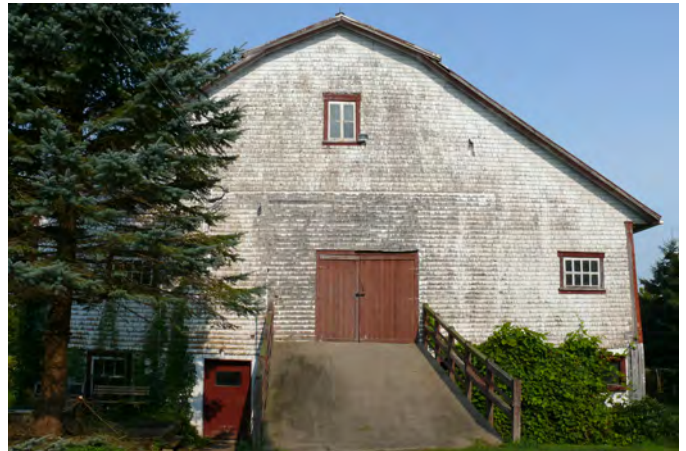
Grange-étable élargie dans les années 1930 pour accueillir les chevaux des paroissiens qui fréquentaient l'église de Notre-Dame-du-Sacré-Cœur-d'Issoudun. La grange-étable est située au 283, rue Principale.
