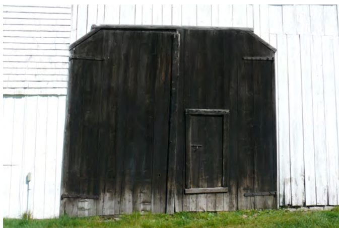
Portes à battants munies d'un guichet sur une grange-étable située au 215, Le Bras Sud, à Saint-Gilles.
