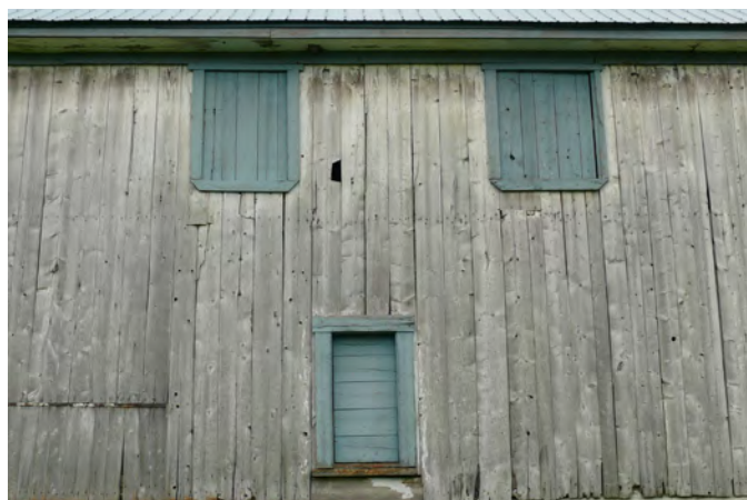
Différentes trappes d'accès d'une grange-étable située au 595, rang Saint-Jean, à Saint-Narcisse-de-Beaurivage.
