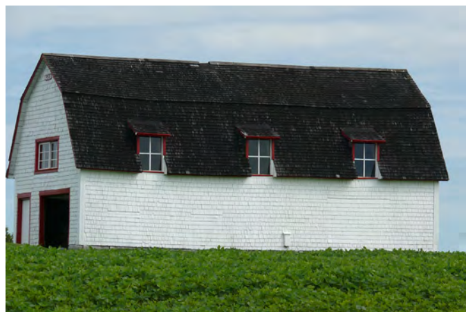
Bâtiment muni de plusieurs lucarnes rampantes au 365, rang Armagh, à Sainte-Agathe-de-Lotbinière.
