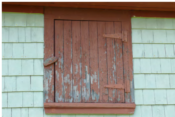
Trappe qui donne accès à la partie supérieure d'un poulailler situé au 482, route 116, à Dosquet.
