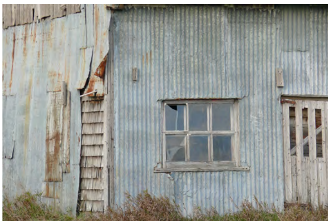
Les revêtements de tôle ondulée qui recouvrent les murs extérieurs des bâtiments agricoles anciens cachent très souvent des revêtements de bois faits de bardeaux ou de planches. Grange-étable située dans le rang du Castor à Leclercville.
