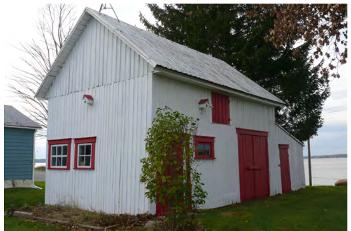
Bâtiment secondaire revêtu de planches de bois à couvre-joint situé au 615, rue Saint-Pierre, à Leclercville.
