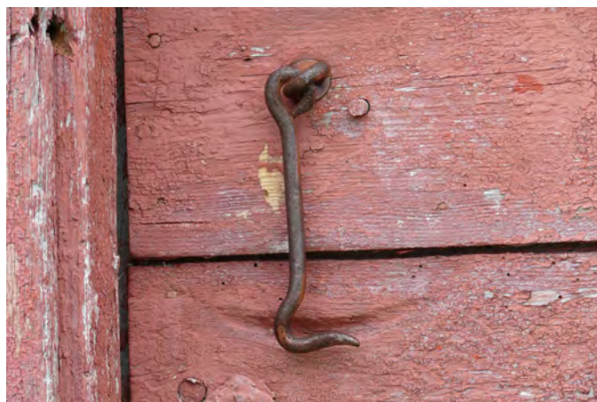
Crochet forgé sur un bâtiment situé au 984, rue Gosford Est, à Sainte-Agathe-de-Lotbinière.
