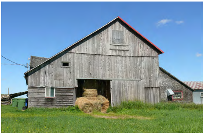
Grange-étable à toiture asymétrique située au 1051, route de Sainte-Agathe, à Sainte-Agathe-de-Lotbinière.
