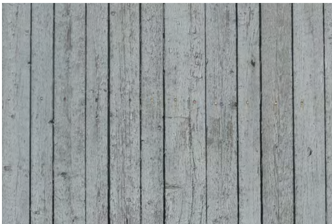
Revêtement de planches de bois verticales sur un bâtiment situé au 176, route 116, à Saint-Agapit.
