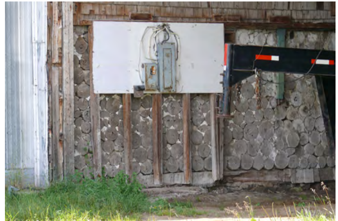
Section d'un bâtiment dont le mur est constitué de billes de bois noyées dans le mortier, au 1036, boulevard Saint-Joseph, à Saint-Flavien.
