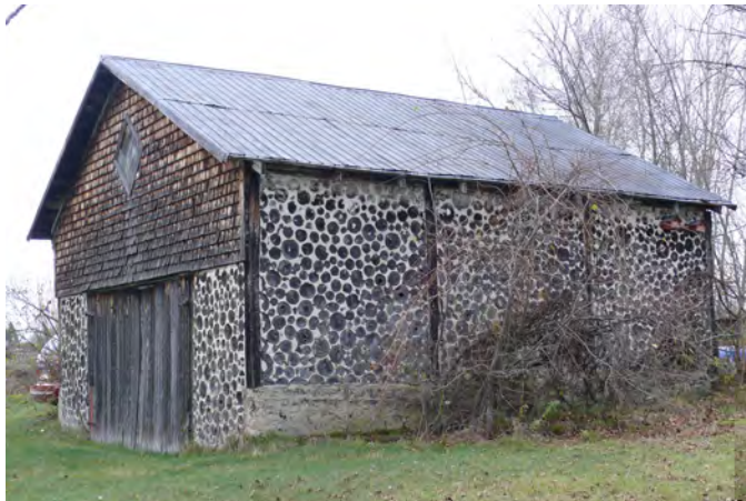
Bâtiment entièrement construit de billes de bois noyées dans le mortier situé au 768, rue Principale, à Saint-Janvier-de-Joly.
