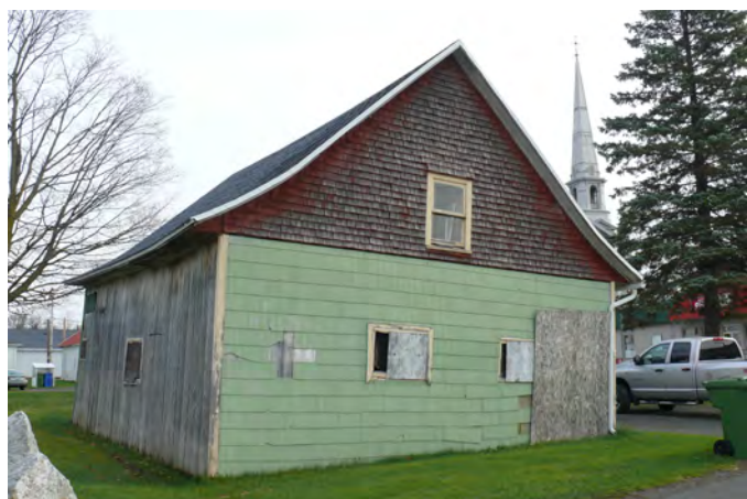
Hangar avec toit à deux versants à base recourbée situé au 2530, rue Principale, à Saint-Édouard-de-Lotbinière.
