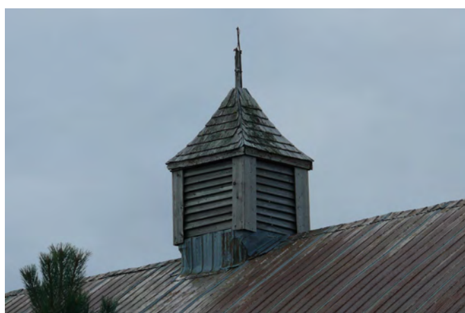
Campanile coiffant une grange-étable située au 800, rang 1 et 2, à Saint-Janvier-de-Joly.
