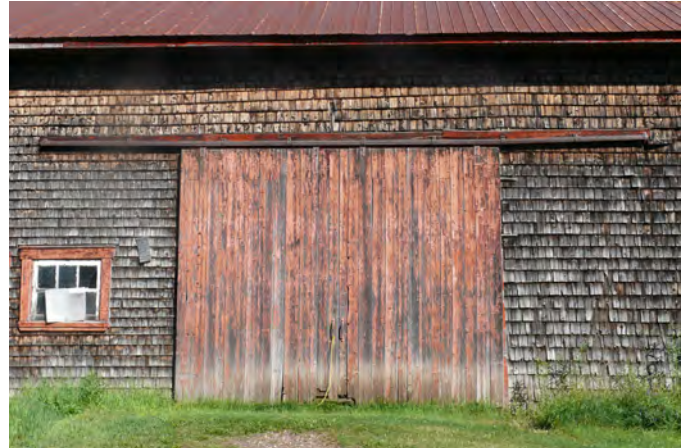
Portes coulissantes sur une grange-étable située au 167, 2 e Rang Ouest, Saint-Agapit.
