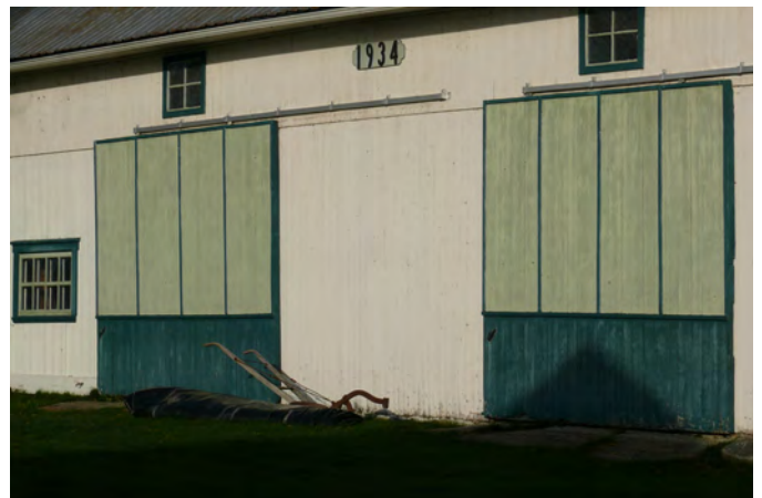
Portes coulissantes sur une grange-étable située au 7666, route Marie-Victorin, à Lotbinière.
