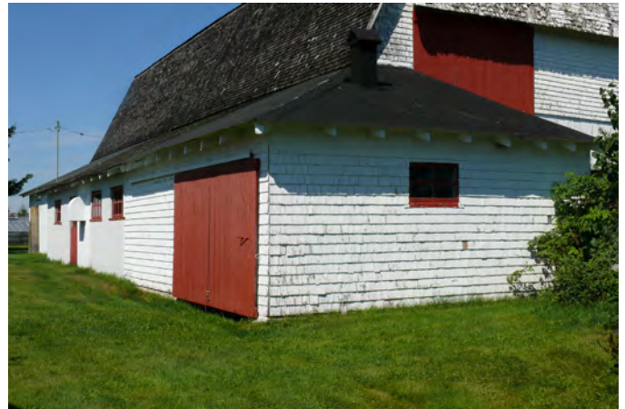
Volume annexe greffé au rez-de-chaussée d'une grange-étable située au 276, rang Sainte-Marie, à Saint-Agapit.
