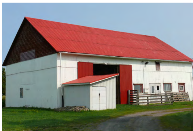
Grange-étable à deux étages, construite dans les années 1940, située au 293, boulevard Saint-Joseph, à Laurier-Station.
