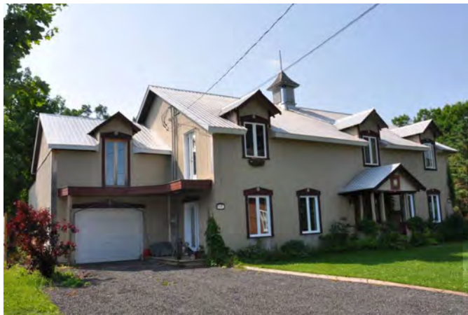
Ancienne grange-étable d'Adélard Houde transformée en résidence unifamiliale et en atelier située au 4441-4443, rue de la Promenade, à Saint-Antoine-de-Tilly. Source : Répertoire culturel de Lotbinière.
