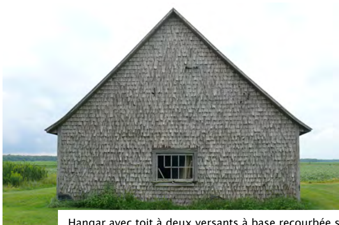
Hangar avec toit à deux versants à base recourbée situé au 1053, boulevard Saint-Joseph, à Saint-Flavien.
