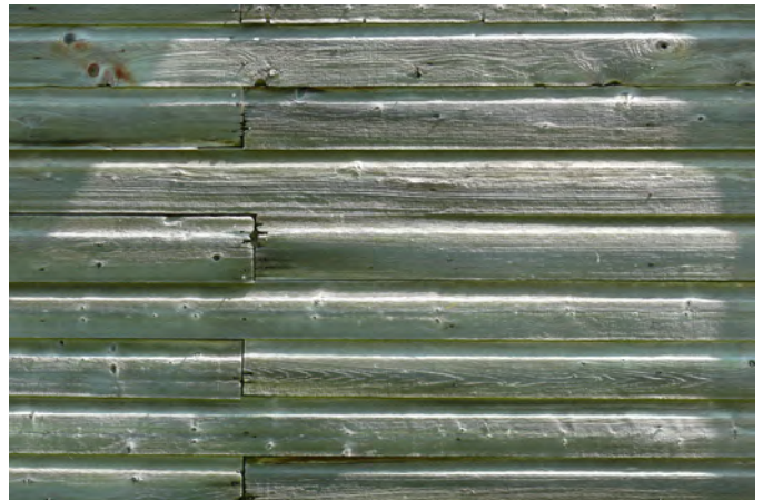
Revêtement de planches à feuillures sur un bâtiment situé au 1089, route de Sainte-Agathe, à Sainte-Agathe-de-Lotbinière.
