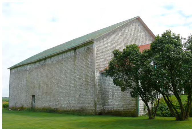
Grange-étable revêtue de bardeaux de cèdre au 1037, boulevard Saint-Joseph, à Saint-Flavien.
