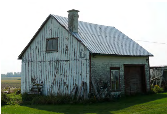
Probable ancien fournil situé au 2355, 2 e Rang Est, à Sainte-Croix.
