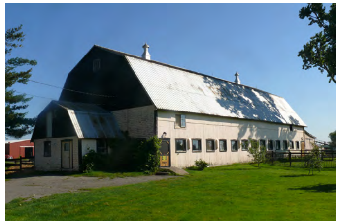
Grange-étable à toit brisé, au profil plutôt évasé, située au 222, route 116, à Saint-Agapit.
