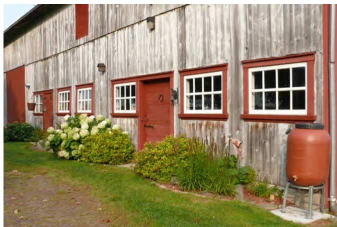
Ces portes et fenêtres encadrées de chambranles peints en rouge donnent beaucoup de caractère à cette grange-étable située au 449, rang Bois-Franc Est, à Notre-Dame-du-Sacré-Cœur-d'Issoudun.
