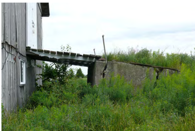
Pont de garnaud en béton et en bois d'une grange-étable située au 247, chemin Craig, à Saint-Patrice-de-Beaurivage.
