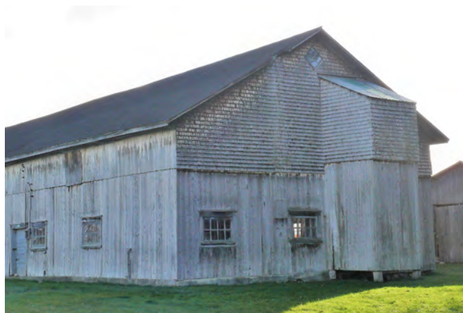
Grange-étable avec une chute à foin située au 7633, route Marie-Victorin, à Lotbinière.
