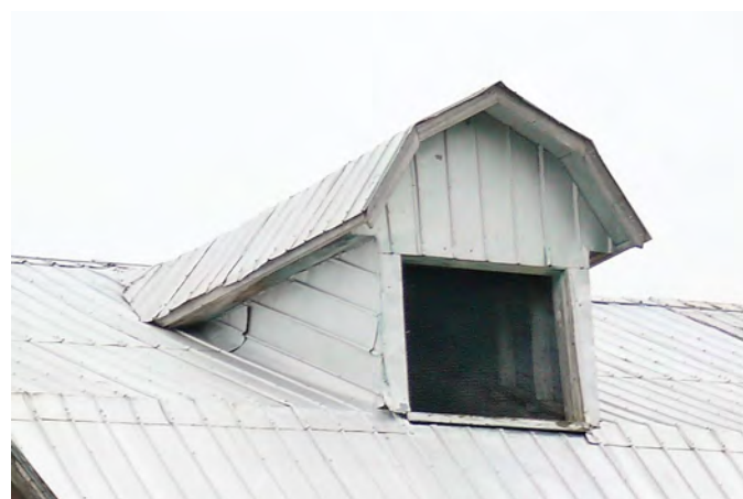
Lucarne à toit brisé sur une grange-étable située au 387, rue Saint-Pierre, à Saint-Narcisse-de-Beaurivage.
