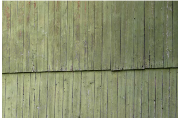
Revêtement de planches de bois verticales sur un bâtiment situé au 381, rang Bois-Franc Est, à Notre-Dame-du-Sacré-Cœur-d'Issoudun
