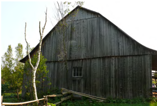
Profil latéral d'un toit brisé à base recourbée sur une grange-étable située au 138, rang Gaspé, à Saint-Apollinaire.
