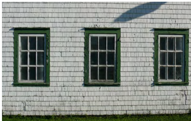
Fenêtres verticales éclairant une étable située au 1240, rue Principale, à Saint-Gilles.
