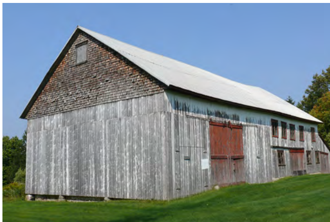
Grange-étable à toit à deux versants située au 3590, route Marie-Victorin, à Saint-Antoine-de-Tilly.
