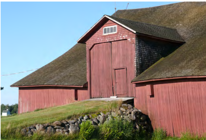
Lucarne de garnaud à pignon sur une grange-étable située au 980, route 269, à Saint-Gilles.
