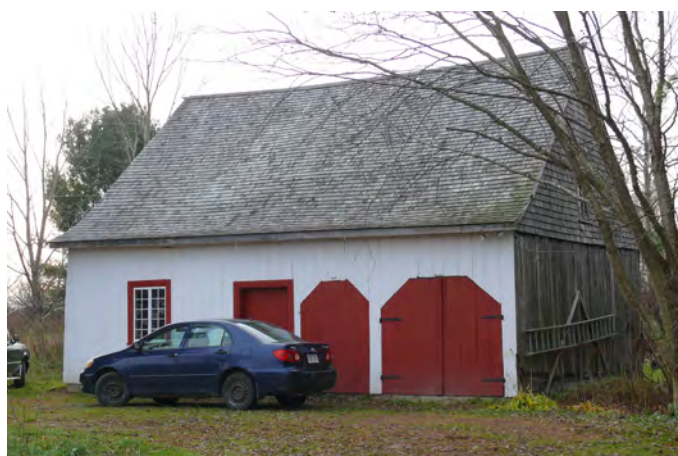
Hangar avec toit à deux versants à base recourbée situé au 124, rang Saint-Michel, à Leclercville.
