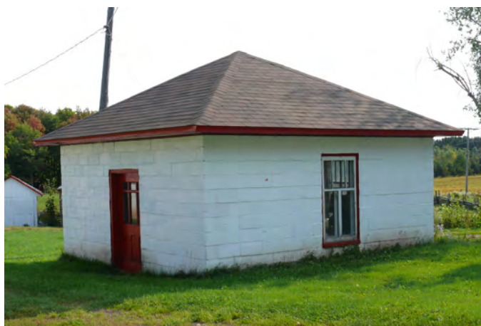
Laiterie surmontée d'un toit en pavillon située au 24, rue Principale, à Saint-Apollinaire.
