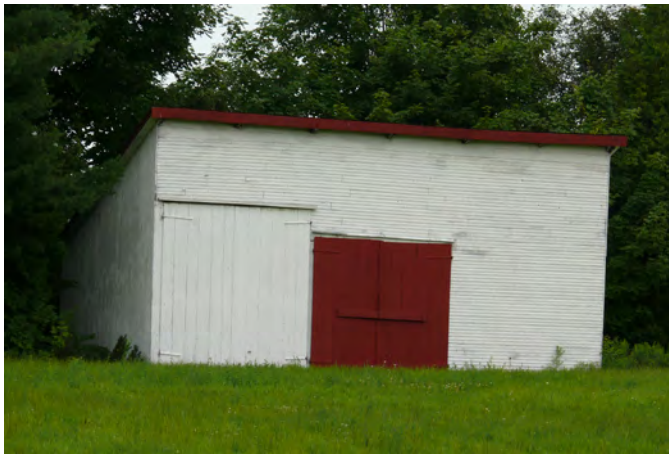
Hangar avec un toit en appentis situé au 376, rang des Chutes, à Saint-Patrice-de-Beaurivage.
