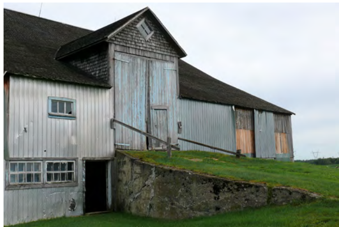
Pont de garnaud en béton sur une grange-étable située au 319, rang Armagh, à Sainte-Agathe-de-Lotbinière.
