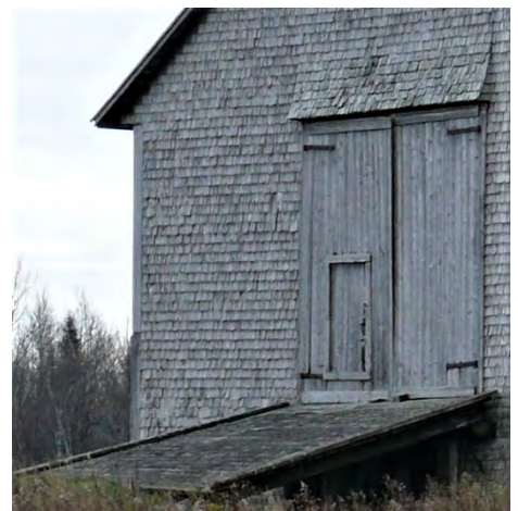
Auvent au-dessus des portes à battants d'une grange-étable située au 433, rang 1 et 2 Est, à Saint-Janvier-de-Joly.
