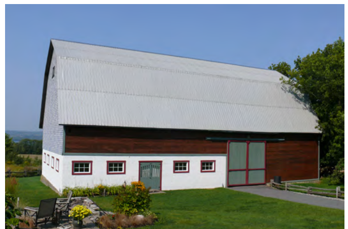
Grange-étable à toit brisé située au 2616, route Marie-Victorin, à Saint-Antoine-de-Tilly.
