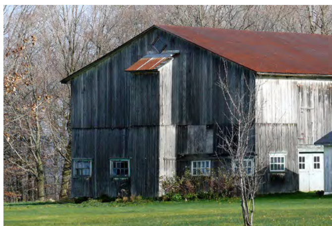
Grange-étable avec une chute à foin située au 7382, route Marie-Victorin, à Lotbinière.
