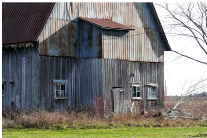
Grange-étable avec une chute à foin située au 7203, route Marie-Victorin, à Lotbinière
