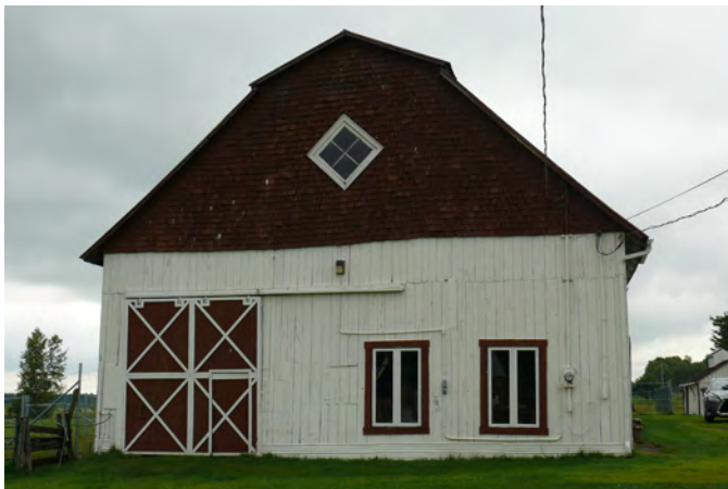
Grange-étable probablement élargie située au 1247, rang des Pointes, à Saint-Flavien.
