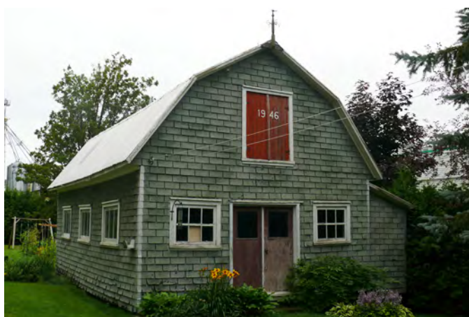
Ancien atelier ou hangar à toit brisé construit en 1943 situé au 365, rue Principale, à Saint-Narcisse-de-Beaurivage.
