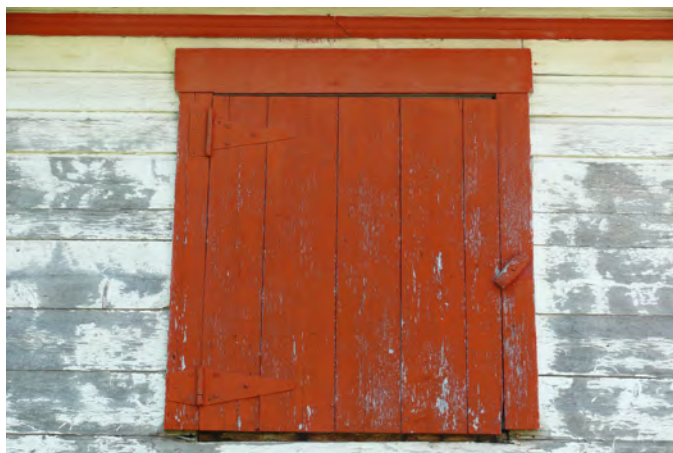
Trappe qui donne accès à la partie supérieure d'un hangar situé au 192, rue Saint-Georges, à Sainte-Agathe-de-Lotbinière.
