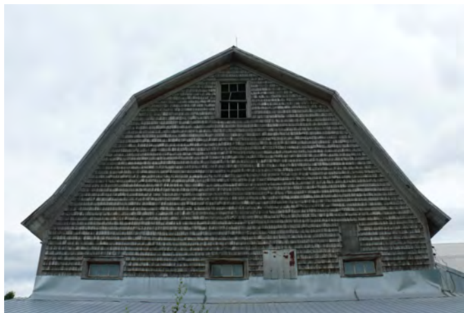
Profil latéral d'un toit brisé courbé sur une vaste grange-étable située au 618, avenue Gauthier, dans le village de Saint-Patrice-de-Beaurivage.
