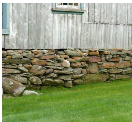
22. Maçonnerie de pierre
