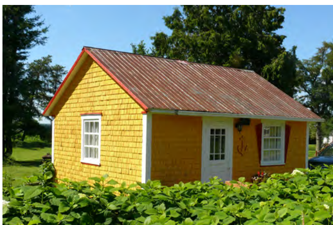
Remise ou hangar situé au 473, rue Gosford Ouest, à Sainte-Agathe-de-Lotbinière.
