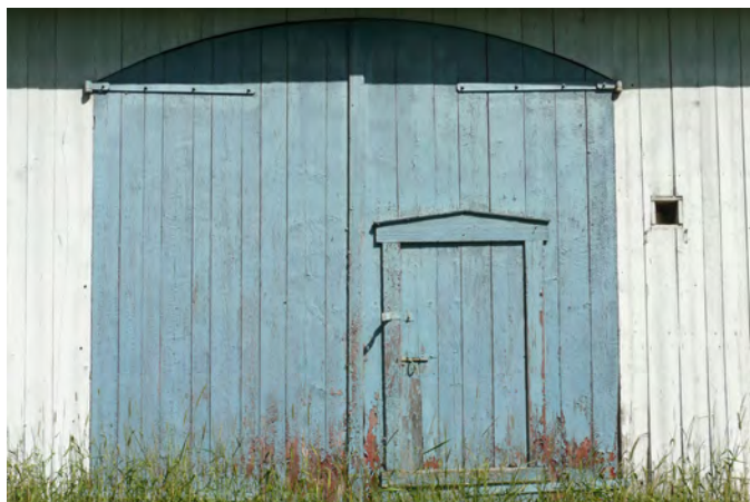
Portes à battants cintrées munies d'un guichet sur une grange-étable située au 249, route 218 Est, à Saint-Gilles.
