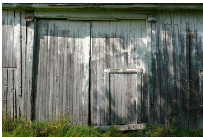
Portes à battants munies d'un guichet sur une grange-étable située au 3740, 3 e Rang Ouest, à Sainte-Croix.
