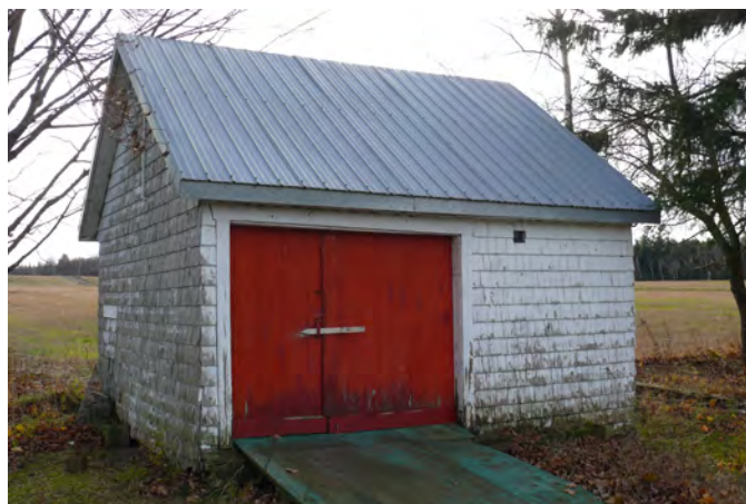
Petit bâtiment ayant probablement servi de laiterie situé au 7191, route Marie-Victorin, à Lotbinière.
