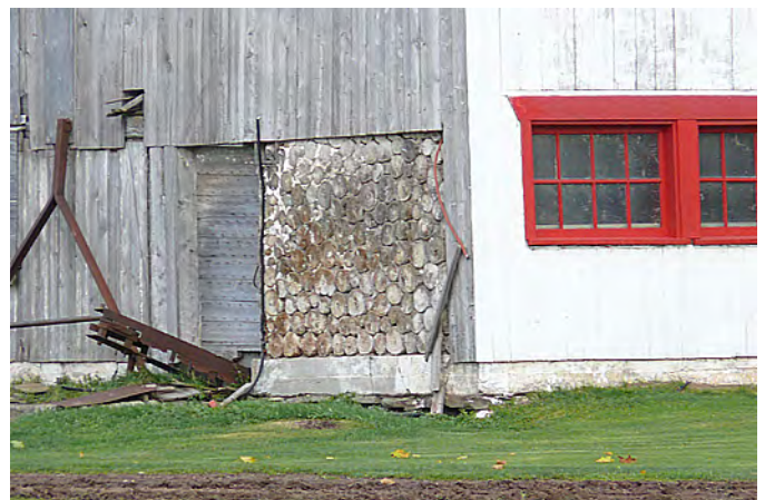
Section d'une grange-étable composée de billes de bois noyées dans le mortier. Bâtiment situé au 1608, rang Saint-Charles, à Saint-Édouard-de-Lotbinière.
