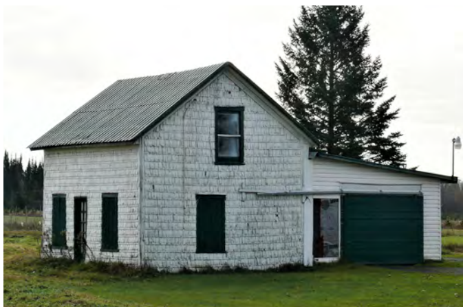
Maison de colonisation transformée en hangar, au 573, 4 e Rang, à Val-Alain.
