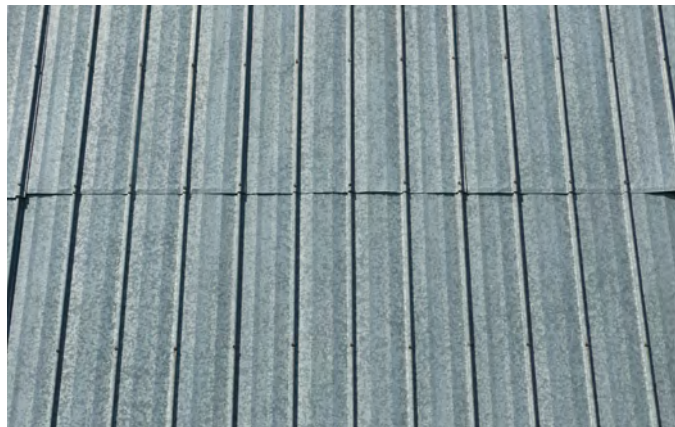
Revêtement de tôle ondulée sur un bâtiment situé au 160, rang Sainte-Marie, à Saint-Agapit.
