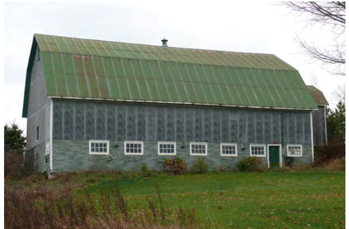
Grange-étable à toit brisé située au 317, Rang 1 et 2 Est, à Saint-Janvier-de-Joly.
