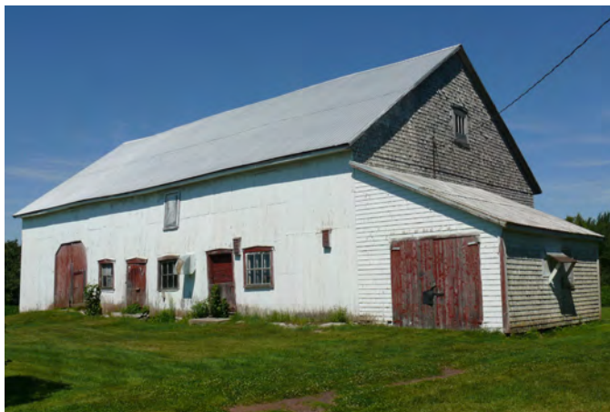
Grange-étable à toit à deux versants greffée d'une remise en appentis située au 286, rang Sainte-Marie, à Saint-Agapit.
