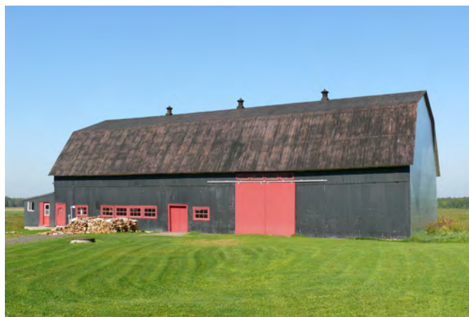
Grange-étable entièrement revêtue de tôle ondulée située au 3610, chemin Bois-Clair, à Saint-Antoine-de-Tilly.
