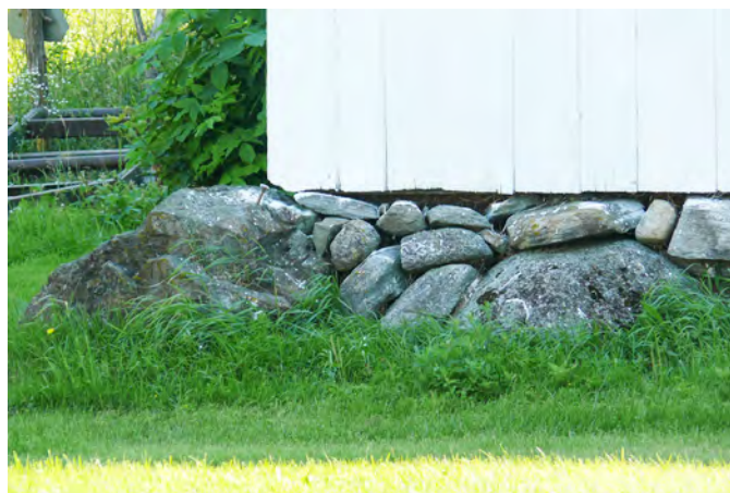
Soubassement en pierre sur une grange-étable sise au 276, rang Sainte-Marie, à Saint-Agapit.
