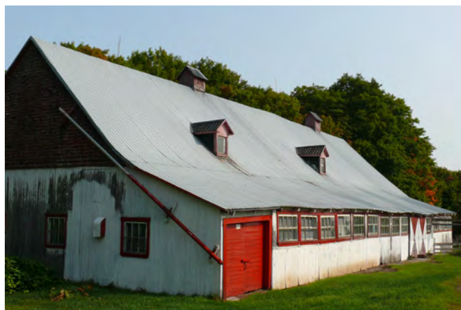
Lucarnes à pignon perçant la toiture d'une grange-étable située au 24, rue Principale, à Saint-Apollinaire.
