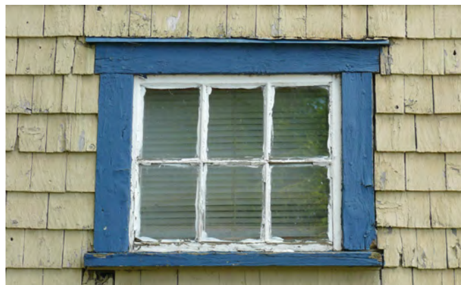
Chambranle formé de planches autour d'une fenêtre d'un bâtiment situé au 1149, rue Principal à Saint-Agait.
