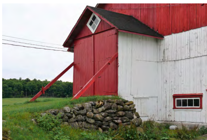
Garnaud en pierres des champs avec la partie en bois qui est couverte sur une grange-étable située au 401, rang Saint-José, à Saint-Sylvestre.
