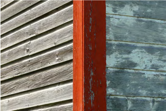
Planche cornière sur un hangar situé au 192, rue Saint-Georges, à Sainte-Agathe-de-Lotbinière.
