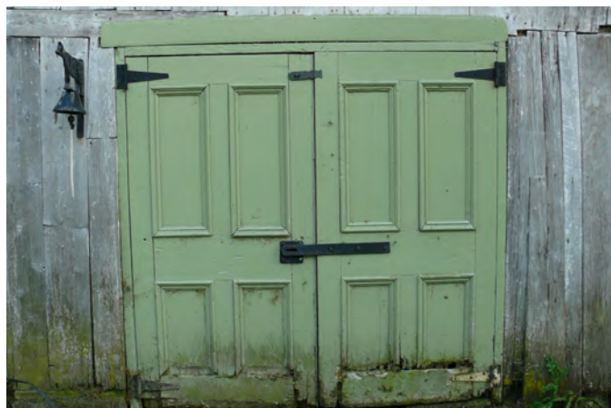
Quincaillerie et pentures de portes sur un hangar situé au 135, rang du Petit-Village, à Sainte-Croix.
