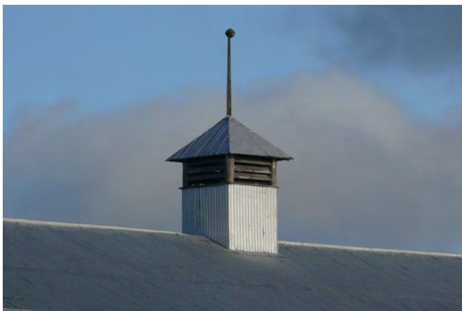
Campanile coiffant une grange-étable située au 7694, route Marie-Victorin, à Lotbinière.
