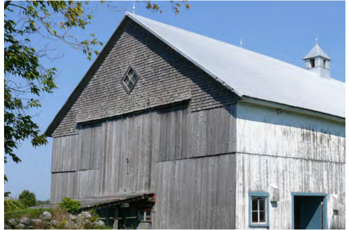
Auvent au-dessus de portes coulissantes d'une grange-étable située au 5040, chemin des Plaines, à Saint-Antoine-de-Tilly.
