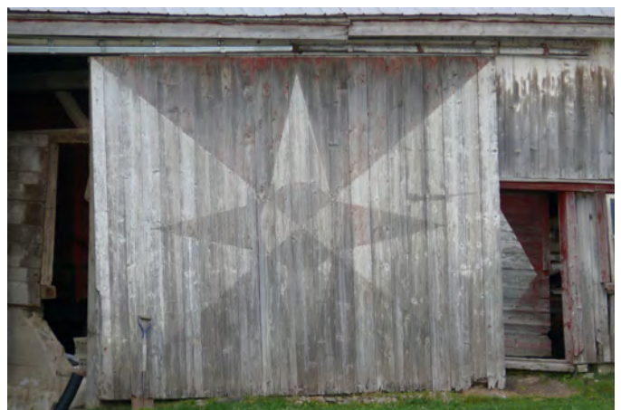
Motifs délavés sur une porte d'une grange-étable située au 2824, route Principale, à Saint-Édouard-de-Lotbinière.
