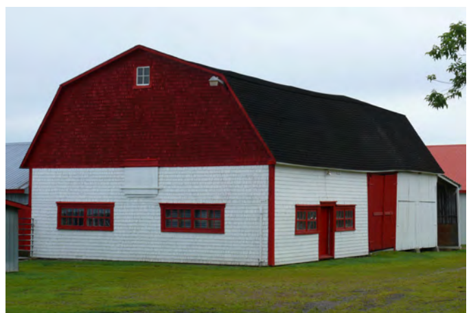
Grange-étable à toit brisé, au profil plutôt évasé, située au 883, chemin Gosford, à Sainte-Agathe-de-Lotbinière.
