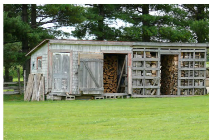
Hangar à bois situé au 986, chemin Gosford, à Sainte-Agathe-de-Lotbinière.
