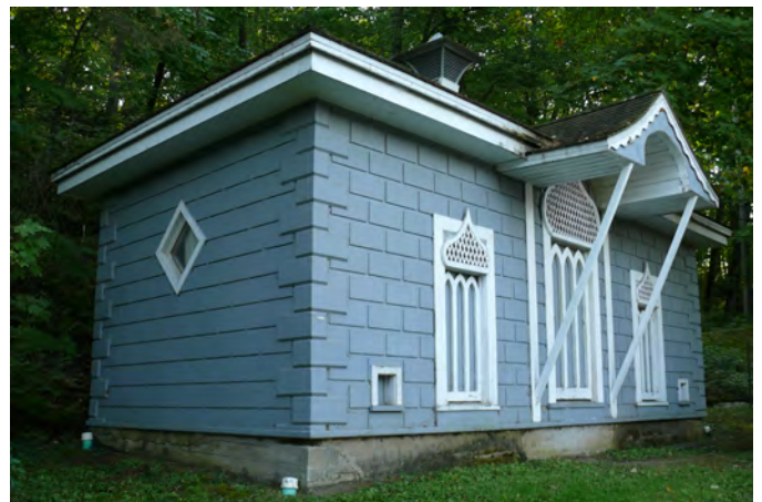
Poulailler érigé au cours des années 1850 dans le style byzantin au Domaine Joly-De Lotbinière situé au 7015, route de Pointe-Platon, à Sainte-Croix.
