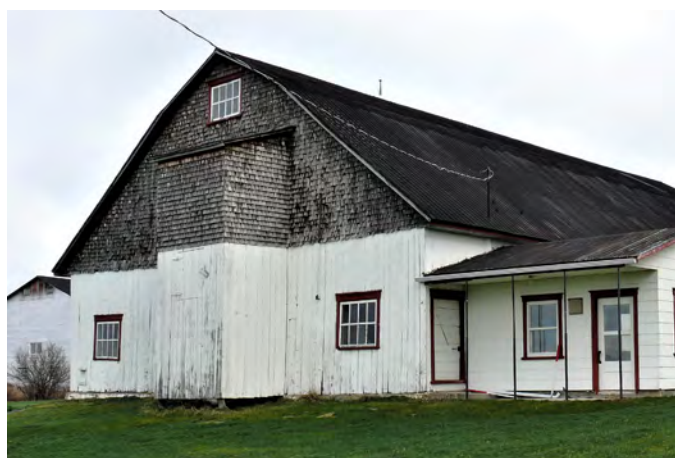
Grange-étable avec une chute à foin située au 7172, route Marie-Victorin, à Lotbinière.
