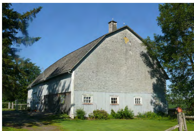
Grange-étable sise au 176, route 116, à Saint-Agapit.
