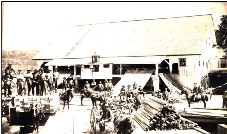
Moulin en 1864 : construit en 1836, il fonctionne jusqu'en 1920 alors qu'il sera remplacé par un plus gros et moderne.
