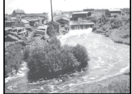
Le moulin Lacquerre en 1938. Il fut rebâti en 1932 après l'incendie.
