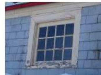
Fig. 84 : Fenêtre du chemin couvert en bois à 12 carreaux.
